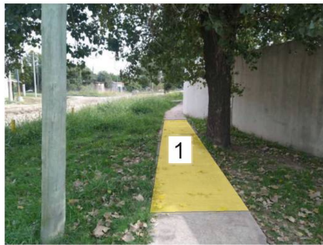
1-Retira vereda existente 7,32 m2. nivelar y colocar losetas cribadas a nivel de vereda existente.
