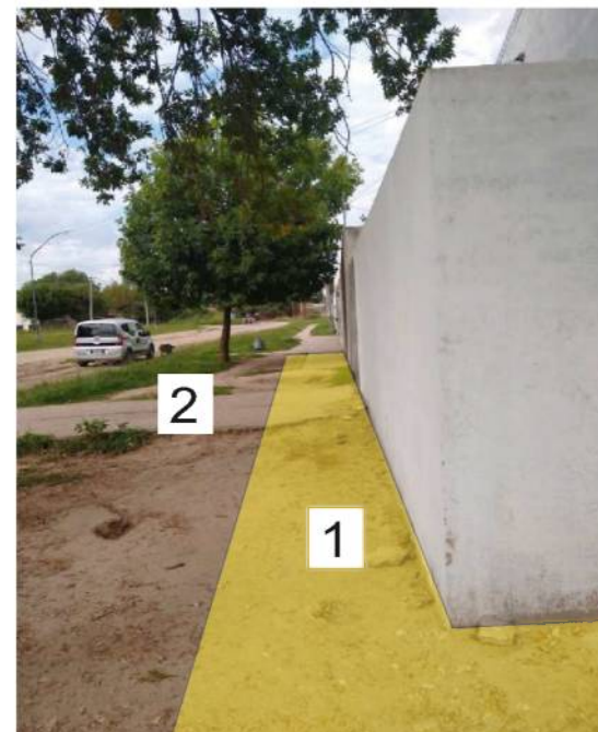
1-Realización de vereda de hgón raspado. 2-Retiro de vereda existente, dejando la superficie en condiciones para realizar cinta verde.
