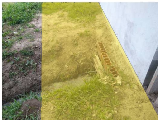
1-Colocación de caños pluviales de 110 de pvc doble. 2-Rellenar con tierra negra y compactar, sobre esta se hará la vereda de hormigón raspado nueva. 3-Realización de vereda de hgón.
